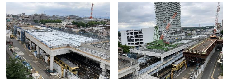
西武新宿線（東村山駅付近）の整備状況
