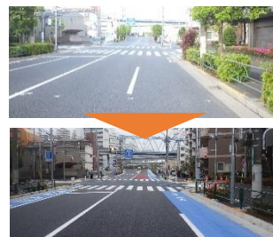
2021年度整備箇所（船堀街道）
