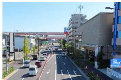
環状七号線 青井 （2021年9月 無電柱化完了区間）
