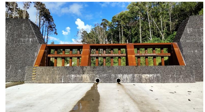
佐久川1号堰堤（大島町）
