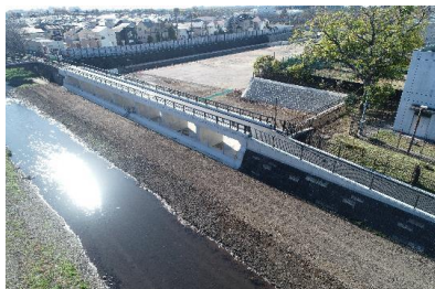
野川大沢調節池（規模拡大） （2021年11月 新規稼働）
