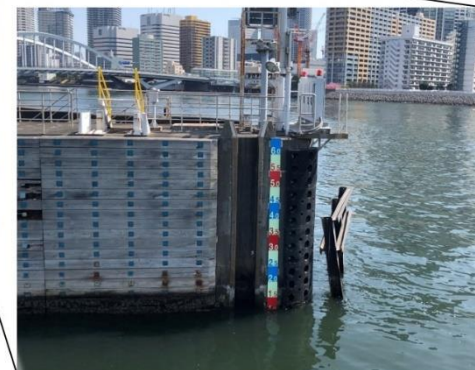
増設した海面ライブカメラ（築地川水門外水側） (左：新たに設置したカメラ、右：カメラ映像)
