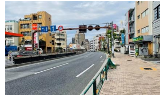
第一次緊急輸送道路の無電柱化 (環状七号線 世田谷区大原一丁目)
