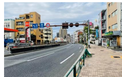
第一次緊急輸送道路の無電柱化 (環状七号線 世田谷区大原一丁目)
