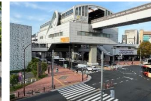
道路のバリアフリー化 (多摩モノレール通り)
