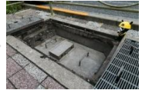
地下鉄通風口の浸水対策
