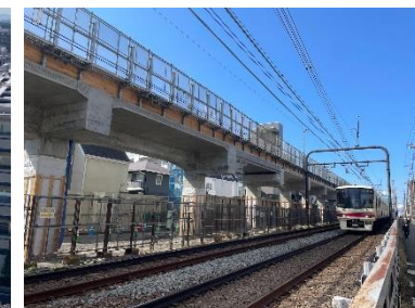
連続立体交差事業（京王京王線）
