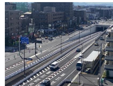
放射第35号線（平和台トンネル）
