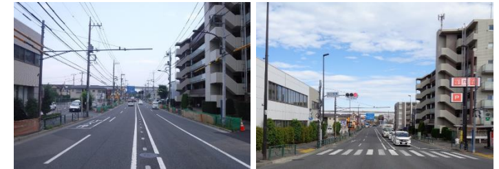
第一次緊急輸送道路の無電柱化 （新奥多摩街道、左：整備前・右：整備後）
