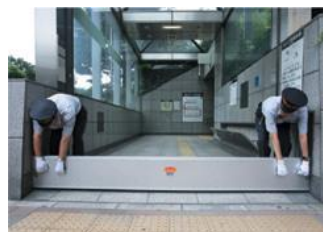
駅出入口に設置した止水板
