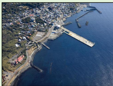
噴火避難用岸壁 船客待合所（噴石対応）
