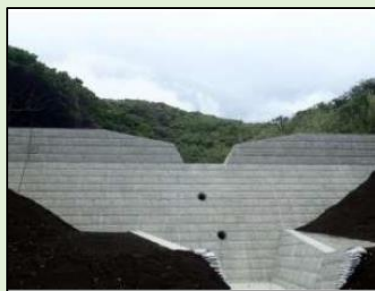
砂防施設（砂防堰堤）
