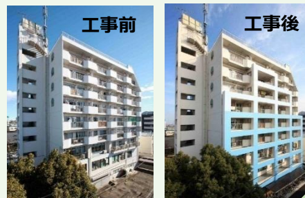
旧耐震マンションの耐震化
