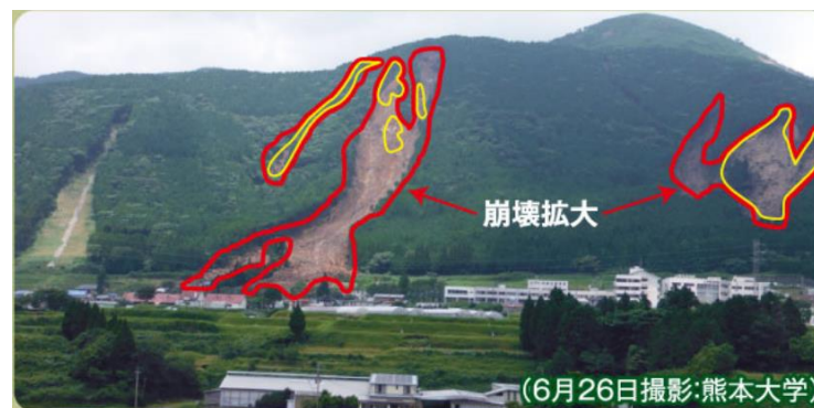
(6月26日撮影:熊本大学) (出典) 熊本県「平成28年熊本地震 土砂災害の被災状況について【被害概要版】」
