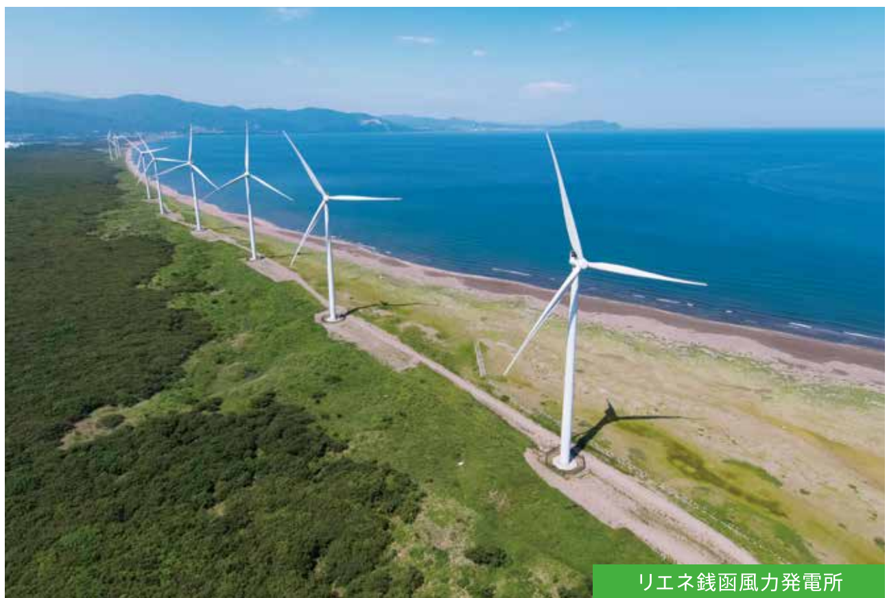
リエネ銭函風力発電所
