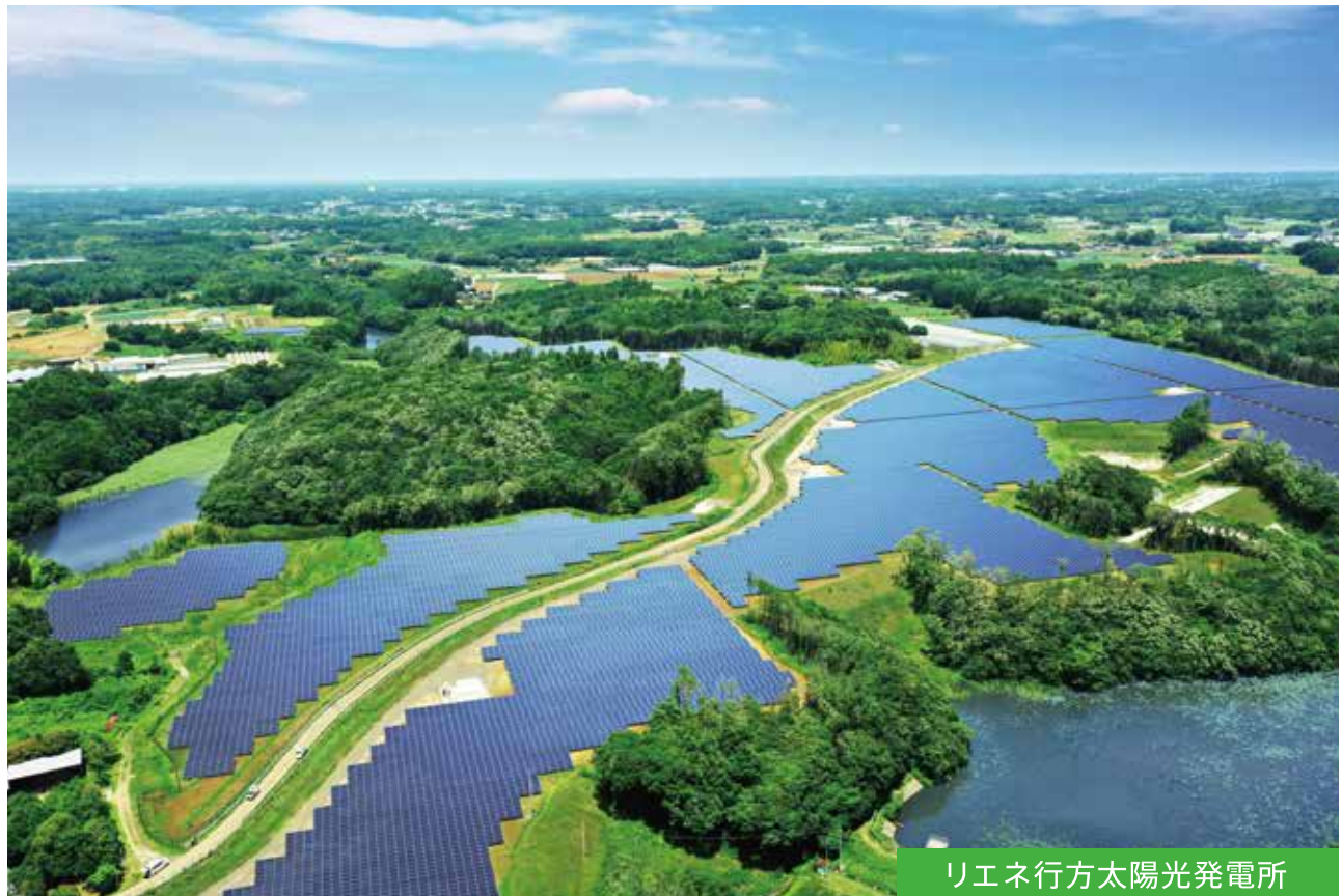
リエネ行方太陽光発電所
