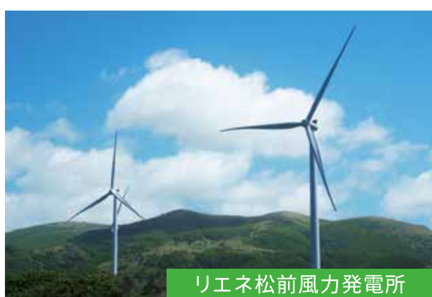
リエネ松前風力発電所
