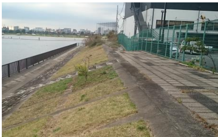
嵩上げを実施する防潮堤（港南地区）
