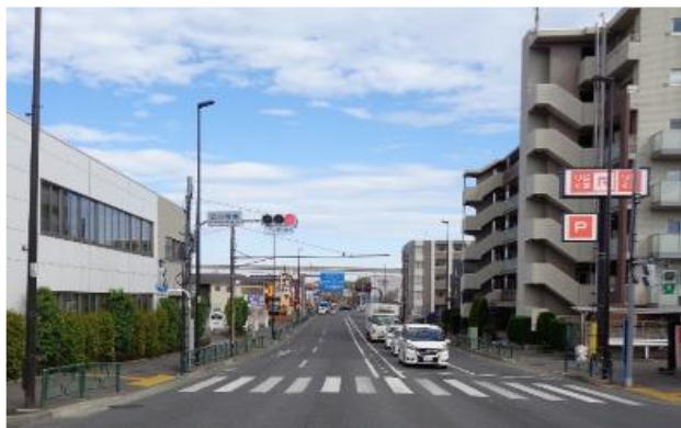
第一次緊急輸送道路の無電柱化（新奥多摩街道）
