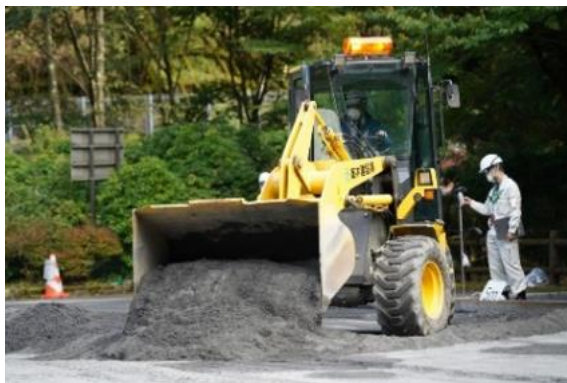
道路除灰訓練の実施状況
