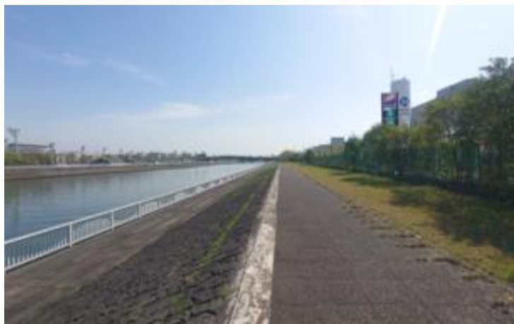
嵩上げを実施する防潮堤（勝島南運河：大田区）
