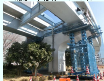
<補修工事(多摩モノレール)>
